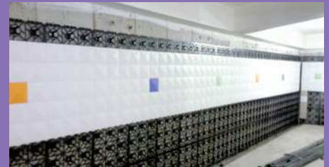
[ 최종 선정 대안 : 방습블럭 설치 ]
